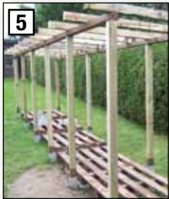
Schritt 5: Dachsparren aus Rahmenhölzern mit Winkelverbindern beidseitig auf der Rahmenkonstruktion befestigen. Schritt 6: Dachsparren mit Schalbrettern beplanken.
