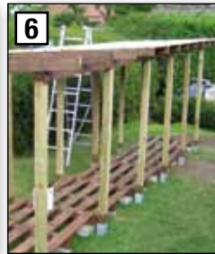
Schritt 5: Dachsparren aus Rahmenhölzern mit Winkelverbindern beidseitig auf der Rahmenkonstruktion befestigen. Schritt 6: Dachsparren mit Schalbrettern beplanken.
