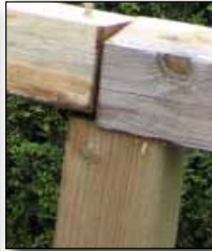
Schritt 4: Vertikale Pfosten mit waagerechten Rahmenhölzern verbinden. Verbindung der Hölzer erfolgt jeweils beidseitig mit Schwerlast-Winkelverbindern.
