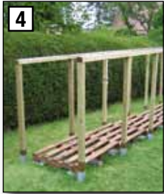
Schritt 4: Vertikale Pfosten mit waagerechten Rahmenhölzern verbinden. Verbindung der Hölzer erfolgt jeweils beidseitig mit Schwerlast-Winkelverbindern.
