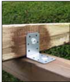
Schritt 5: Dachsparren aus Rahmenhölzern mit Winkelverbindern beidseitig auf der Rahmenkonstruktion befestigen. Schritt 6: Dachsparren mit Schalbrettern beplanken.
