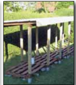
Schritt 5: Dachsparren aus Rahmenhölzern mit Winkelverbindern beidseitig auf der Rahmenkonstruktion befestigen. Schritt 6: Dachsparren mit Schalbrettern beplanken.
