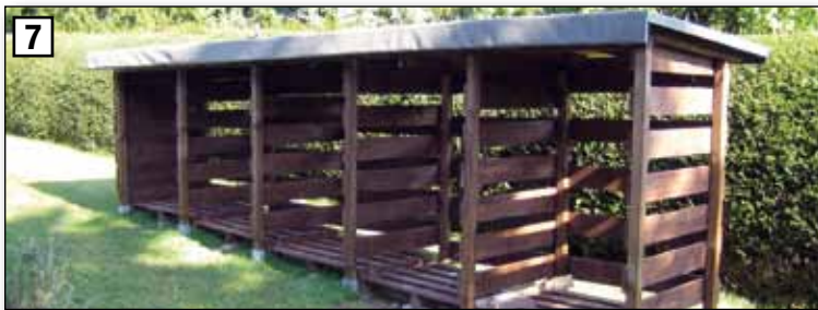
Schritt 7: Dach mit Dachpappe auslegen. Seiten- und Rückwände mit Schalbrettern verkleiden. Holzunterstand mit Holzschutzfarbe anstreichen.
