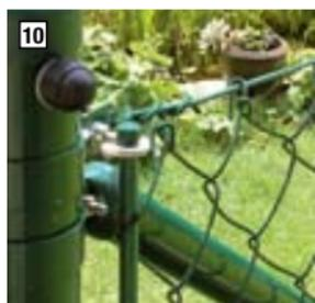
Durch die ersten Maschen des Maschendrahtgeflechts wird der Geflechtspannstab gesteckt. Der Geflechtspannstab wird dann zusammen mit dem Maschendraht in den Haken der Schellen eingehakt. Anschließend wird der Maschendraht abgewickelt und auf Maß abgeschnitten. Durch die letzte Masche kommt ebenfalls ein Geflechtspannstab, der in den Haken der Schellen eingehakt wird. Mit Geflechtspannstäben können Sie später, wenn sich das Maschengewebe gedehnt hat, den Zaun schnell und ohne Aufwand nachspannen.
