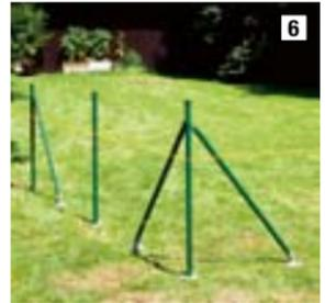
Torfpfosten müssen mit einer Tiefe von etwa 450 mm einbetoniert werden.
