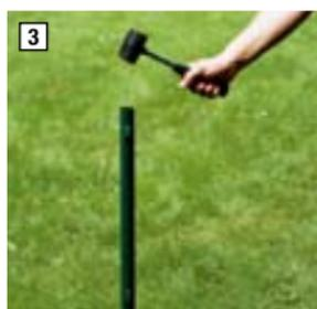
3 Sind alle Bodenhülsen eingeschlagen, können Sie anschließend die Zaunpfosten setzen. Die Pfosten werden mit einem Gummi- oder Holzhammer in die Bodenhülsen eingeschlagen. Bitte vorher die Kunststoffkappe auf dem Rohrende entfernen.
