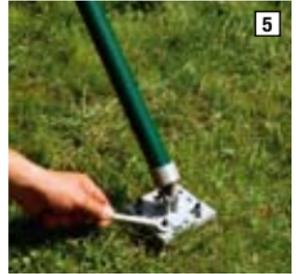
Der Abstand von Pfosten zu Pfosten sollte nicht mehr als 2,50 m betragen. Jeder Anfangs-, End- und Torfpfosten muss durch eine Strebe verstärkt werden. Eckpfosten erhalten zwei Streben. Die Streben stehen jeweils im Zaunverlauf. Bei besonders großen Zäunen müssen auch auf gerader Strecke die Pfosten noch alle 30–35 m durch Streben gestützt werden.
