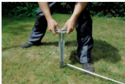
Positionieren Einschlagbodenhülse
